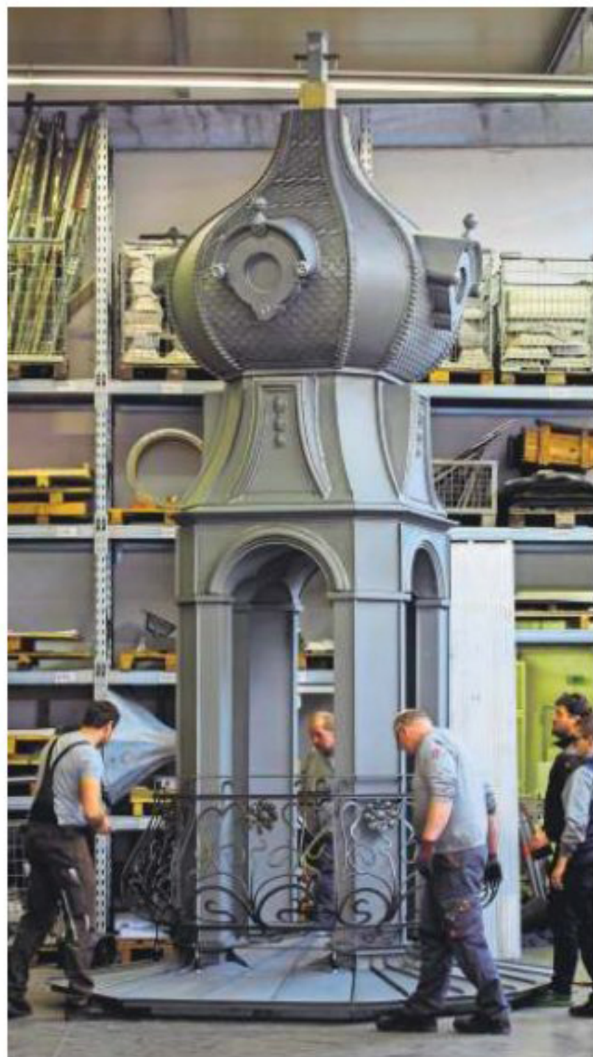
Das Gerüst ist abgebaut, das Geländer wird angebracht. Auch dieses Detail ist nur Zierde. Die Laterne ist nicht begehbar.
